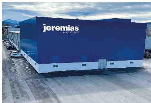
Centro logistico Iurreta (Bilbao).
