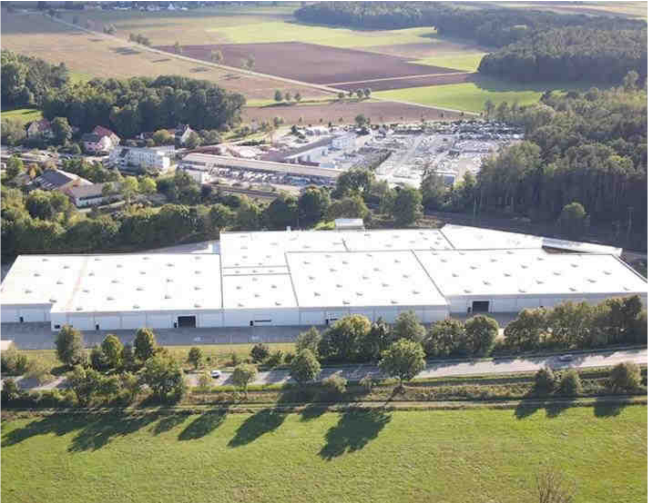
Centro Productivo Alemania – sistemas modulares metálicos
